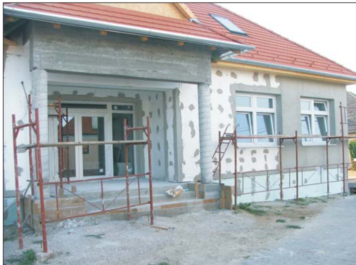
Az egykori iskola épületének felújítása.
